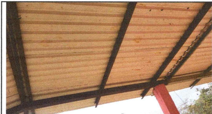
Foto1: MANTENIMIENTO DE COSTANERAS DE METAL
