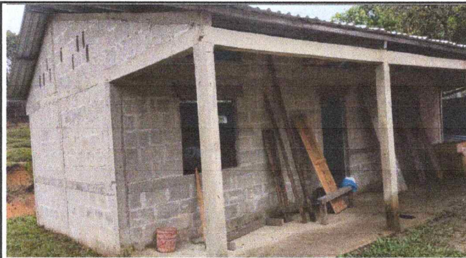
Foto 9: MANTENIMIENTO DE PARED RUSTICA POR REPELLO MONOCAPA.
