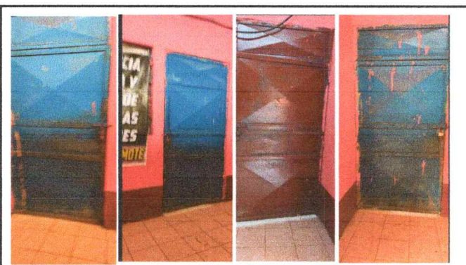
Foto 4: MANTENIMIENTO DE CUATRO PUERTAS DE METAL DE AULAS.
