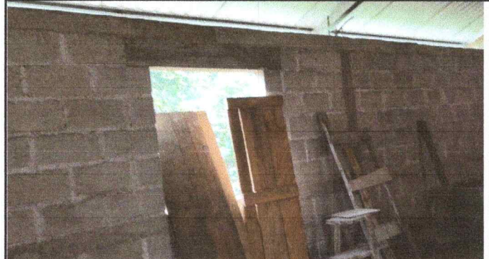
Foto 8: MANTENIMIENTO DE VENTANA DE MADERA A VENTANA DE METAL, COCINA.
